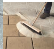
Jointoiment au sable polymère recommandé
