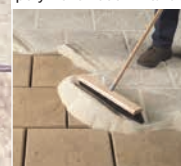
Jointoiement au sable polymère recommandé
