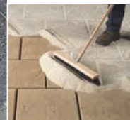
Jointoiment au sable polymère recommandé
